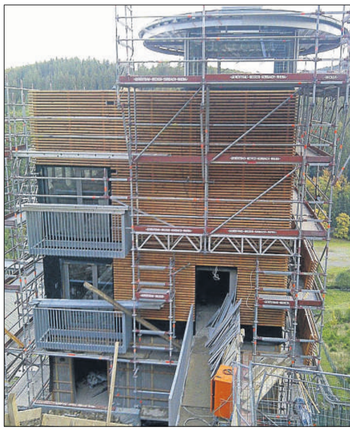
Zum Weltcup-Skispringen fertig: Der neue Kampfrichterturm an der Mühlenkopfschanze. Foto: ds
